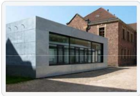
Druck- und Versandzentrum des LZfD Karlsruhe mit feuerverzinkter Blechfassade
